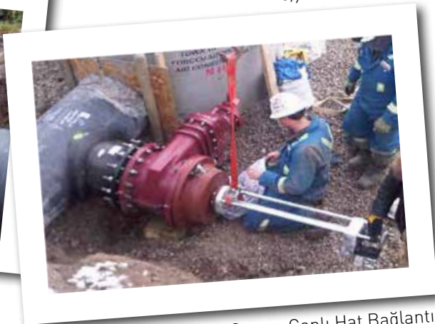
Türkiye - Endüstriyel EF Seme Kullanımı Turkey - Industrial EF Saddle Application
