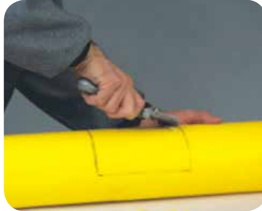
Oksitli tabakanın traşlanması/ Scraping the oxidated layer
